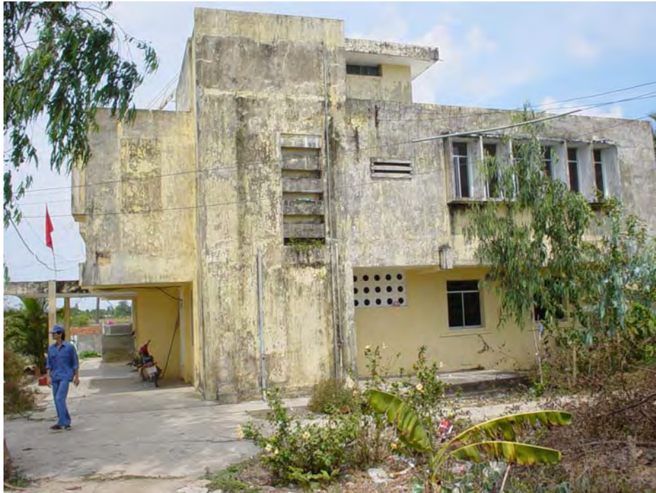
Fig. 2. Main building of the Bac Lieu Observatory
